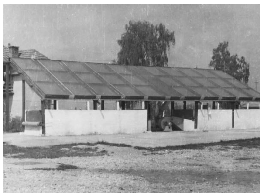
Fig. 37. Instalație de uscare semințe cu panouri solare / Seed drying system with solar panels
